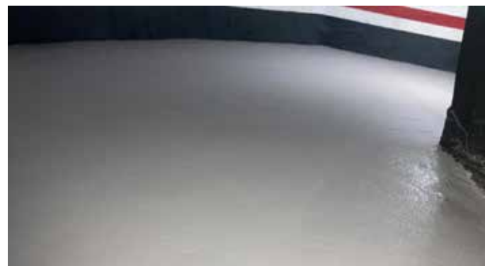
Acabado suelo sistema IQM INDUSTRIAL FLOOR RAL 7036
