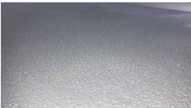
Suelo antideslizante sistema IQM INDUSTRIAL FLOOR clase 3 RAL 7036
